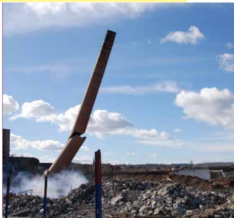
La cheminée de l'usine, haute de plusieurs dizaines de mètres, et monument emblématique témoin de ce passé industriel, a été dynamitée en mars.
